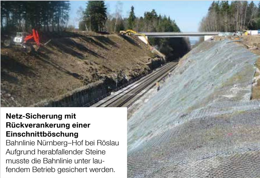
**Netz-Sicherung mit Rückverankerung einer Einschnittböschung**
