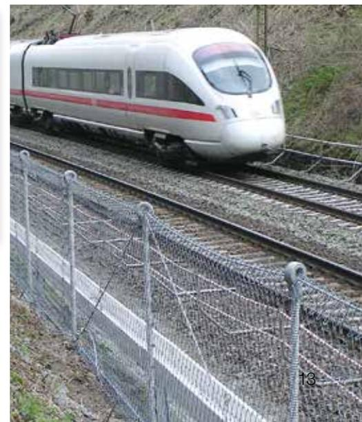
Gleisabsperung mit Steinschlagschutz bestehend aus ISCHEBECK-Traggliedern mit Ankerkopfsen und Sechseckgeflechtbespannung
