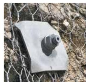
Beispiele von Systemkrallenplatten der Netzhersteller, mit feuerverzinkter Kugelbundmutter TITAN.
